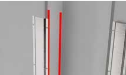
Montage von Versteifungsprofilen
